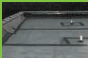
この露出している屋上の場合、温度の低い部分にはおそらく水分が溜まっています。テープでマークを付けて、コア・サンプルで調べましょう。
